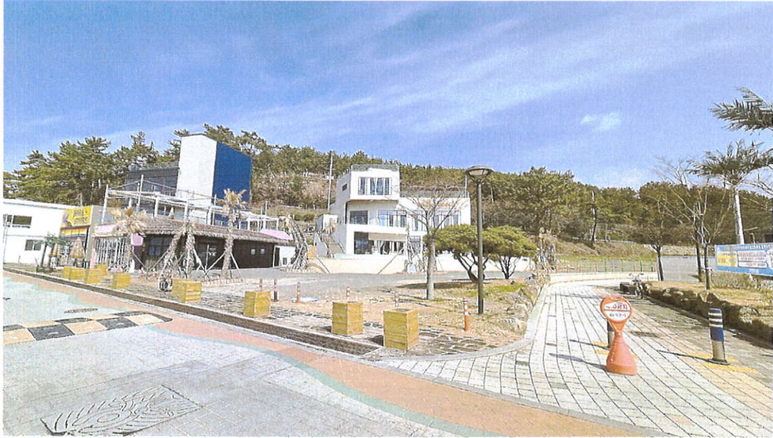
본건 전체 전경 사진
