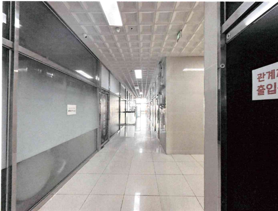
1층 복도 전경
