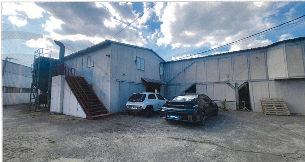
2. 기호(4) 건물 전경
