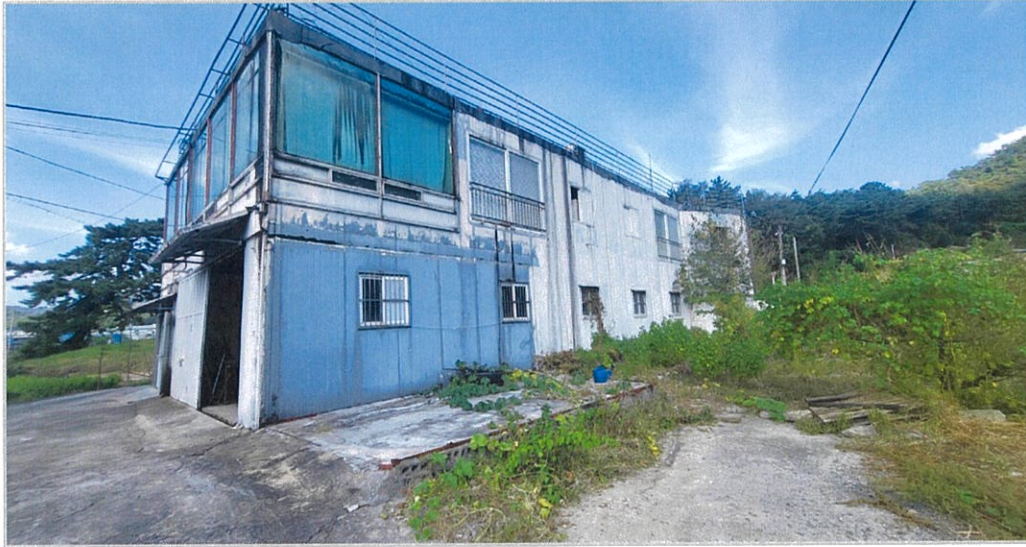
5. 기호(3) 건물 전경
