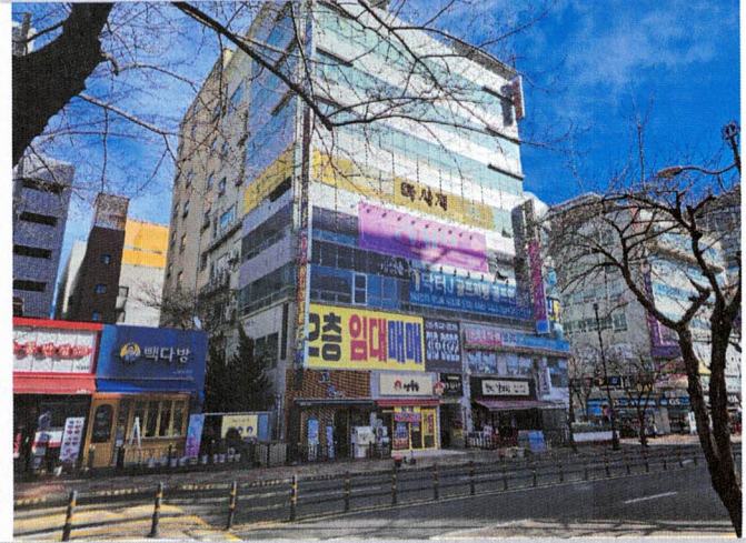
< 본건 외부 전경 >
