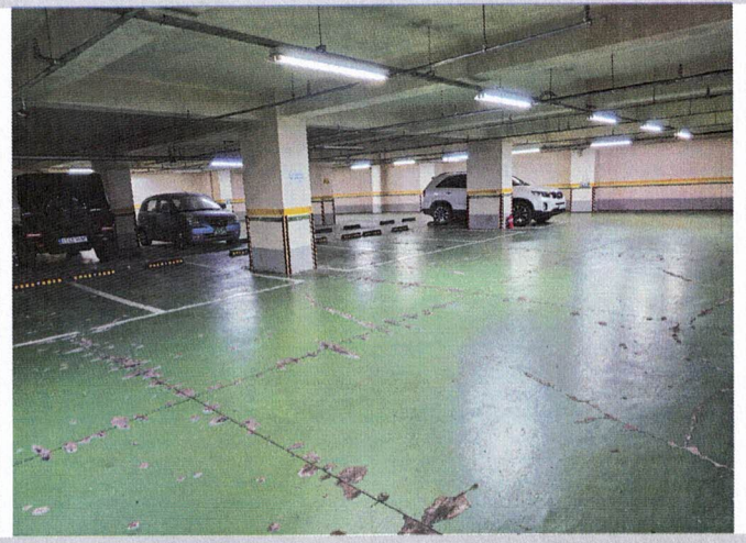
< 지하2층 공용 주차장 >
