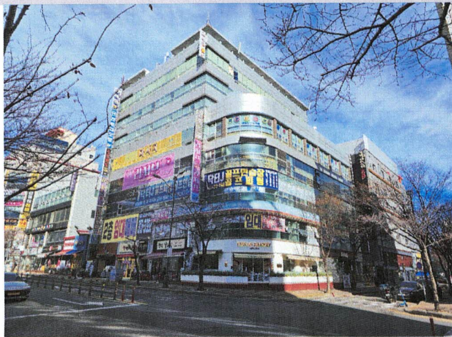
< 본건 외부 전경 >
