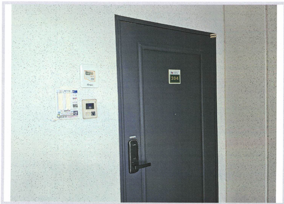
< 본건 세대 출입문 >
