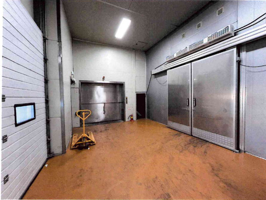
기호 5) 1층 냉동실, 화물용 리프트 전경
