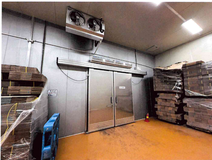
기호 5) 1층 냉장실 전경
