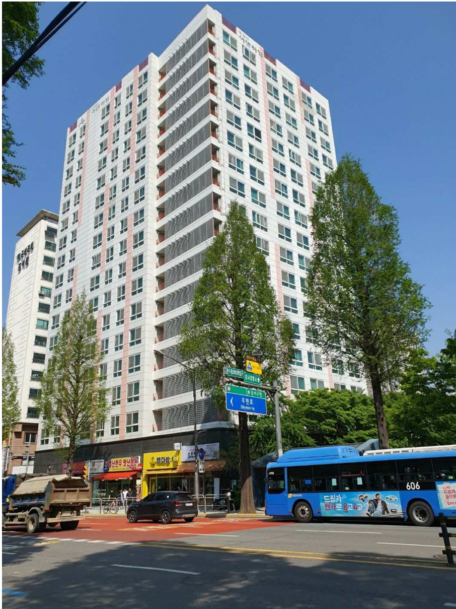
[대상물건이 속한 1동의 건물 전경]
