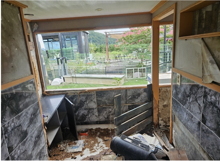
[ 본건 기호(2) 건물 내부 전경 ]
