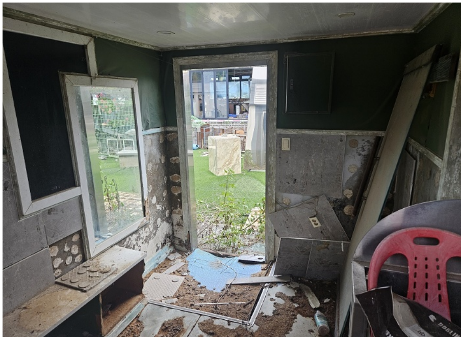
[ 본건 기호(2) 건물 내부 전경 ]
