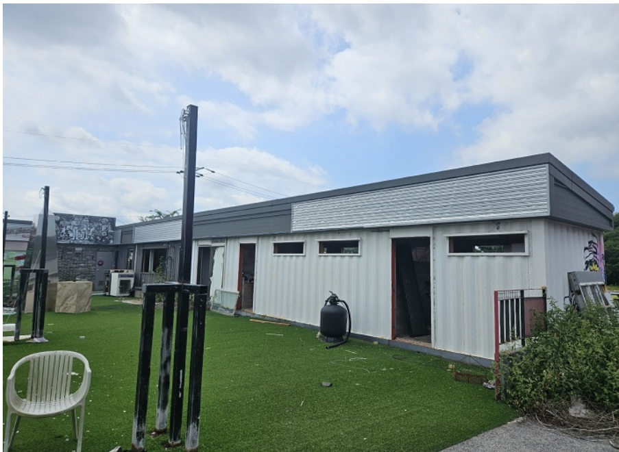
[ 본건 기호(2) 건물 전경 ]
