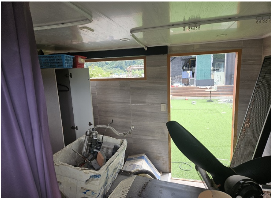
[ 본건 기호(2) 건물 내부 전경 ]
