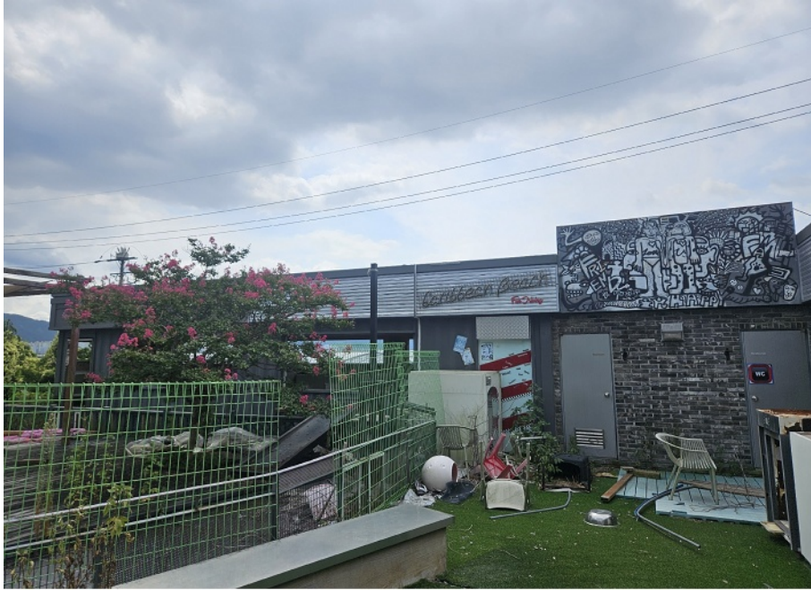
[ 본건 기호(2) 건물 전경 ]
