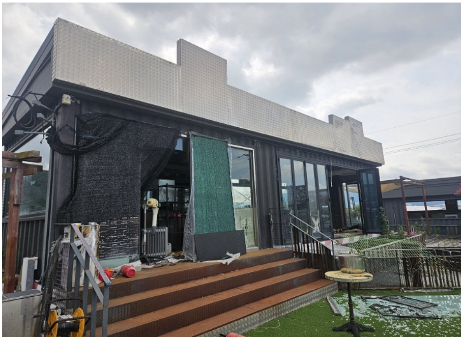
[ 본건 기호(1) 건물 전경 ]
