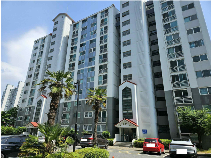
본건 외부 전경
