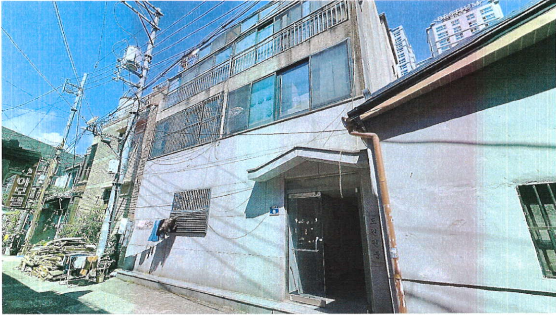
본건 토지 및 건물 사진
