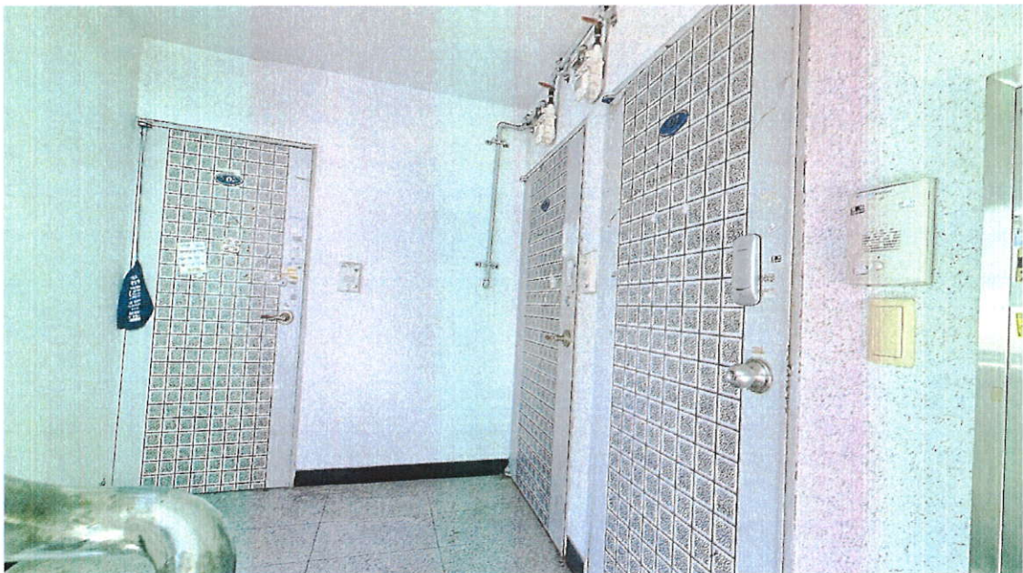
본건 건물 3층 사진
