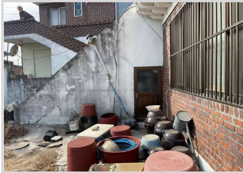
제시외 건물 ㄴ) 전경
