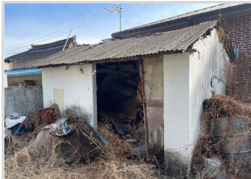
제시외 건물 ㄱ) 전경
