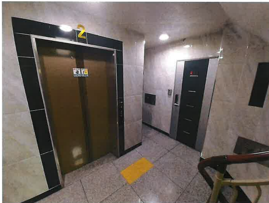
본건 건물 2층 복도
