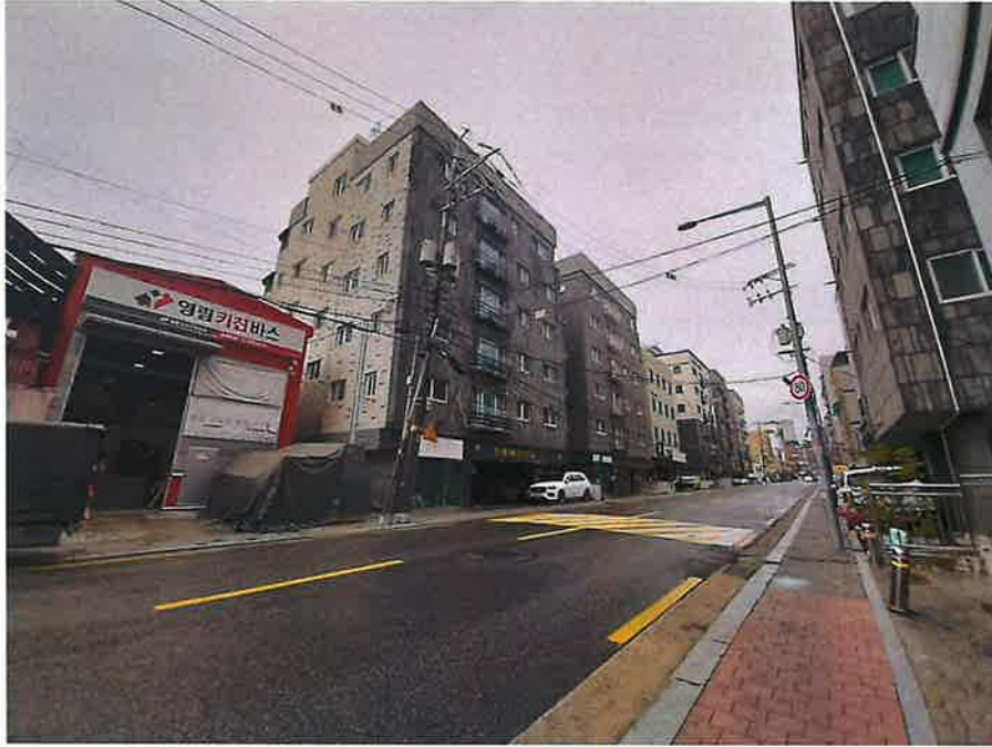
본건 건물 전경
