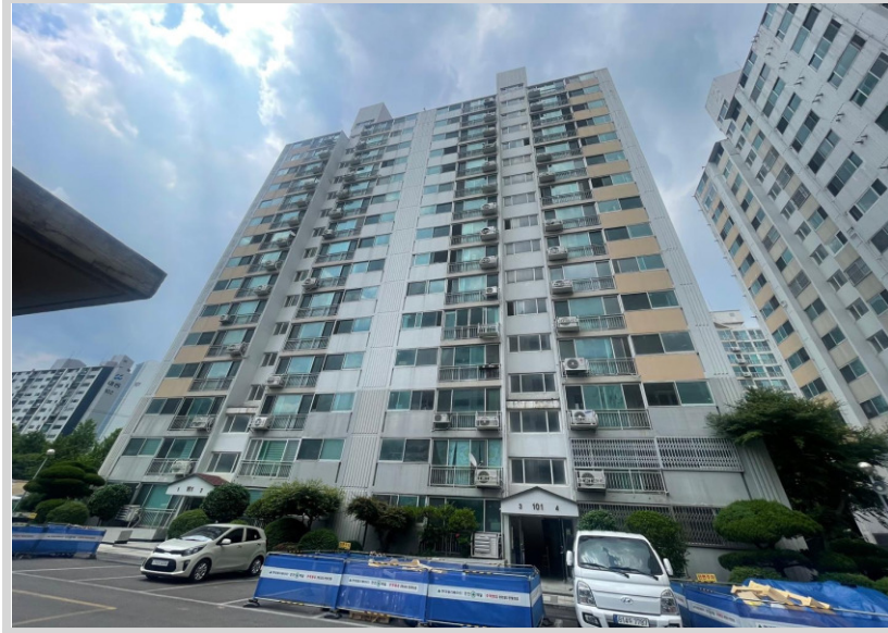
본건 건물 전체 전경
