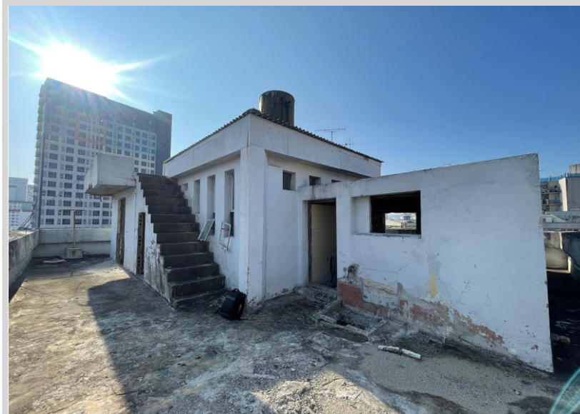
제시외 건물 ㄱ) 전경
