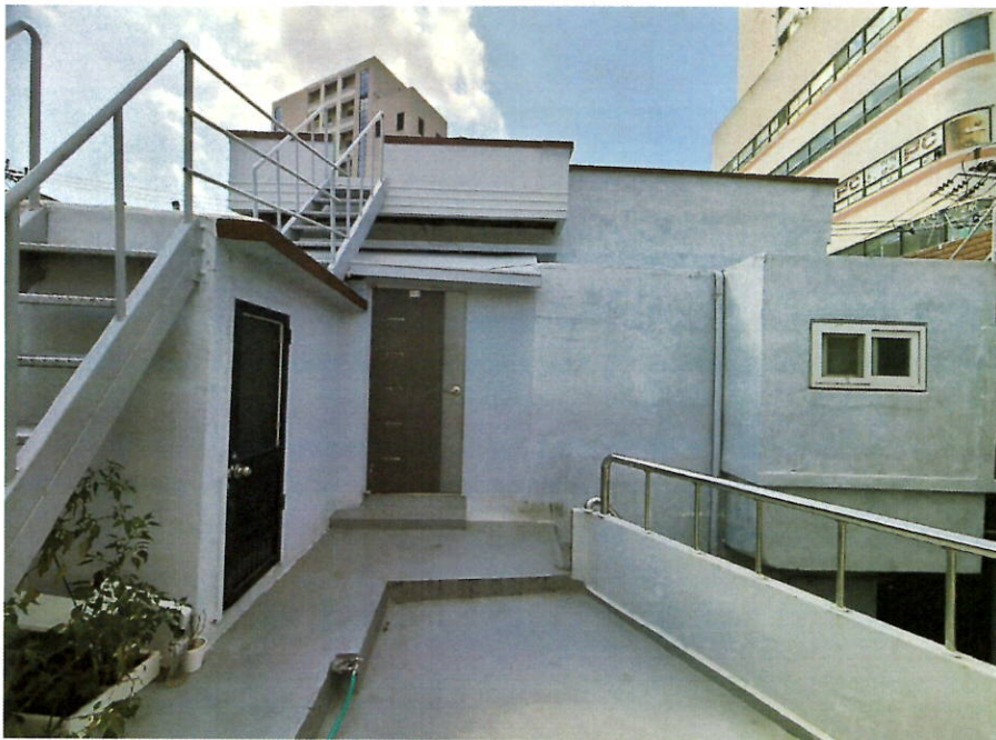
일련번호(2) 2층 및 제시외건물(ㄷ)
