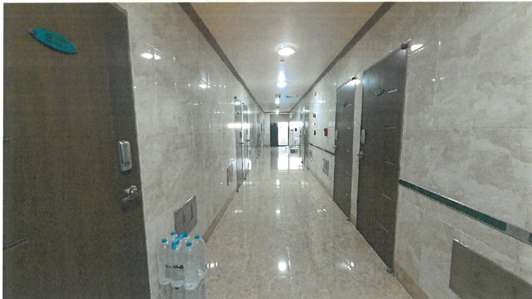
본건 기호2)건물 3층 내부
