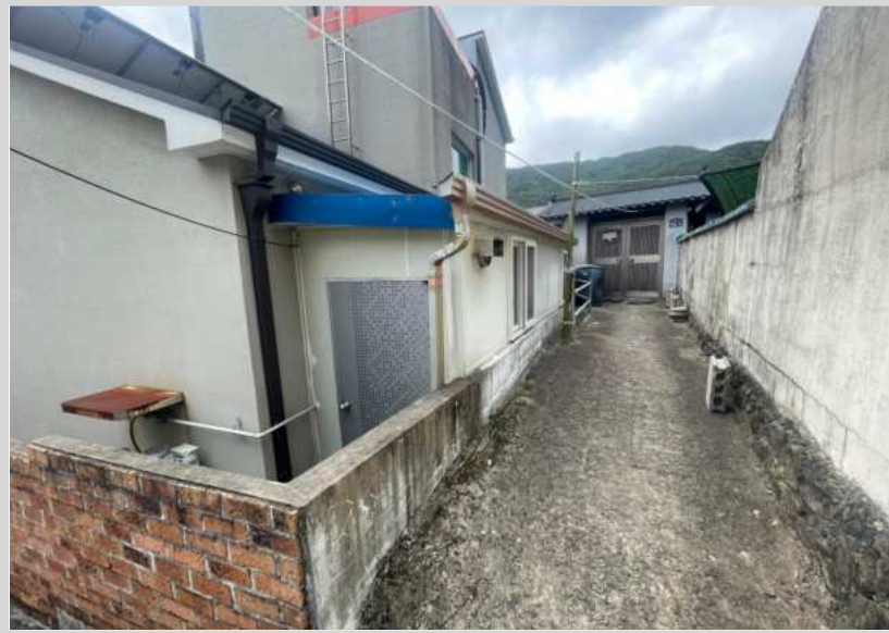
제시의 건물 ㄱ) 전경
