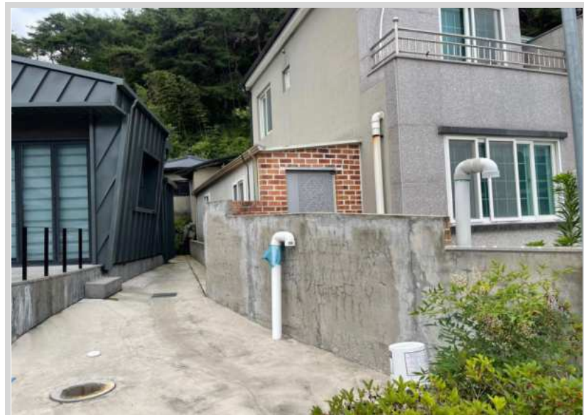
제시외 건물 ㄱ) 전경
