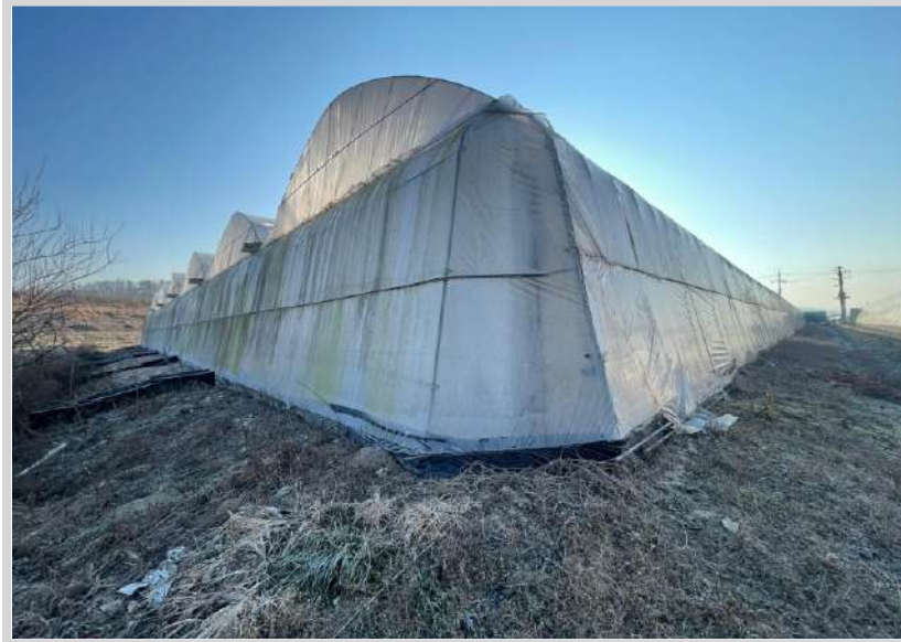
제시외 건물 ㄱ) 전경
