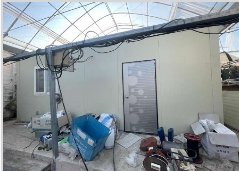
제시외 건물 ㄴ) 전경
