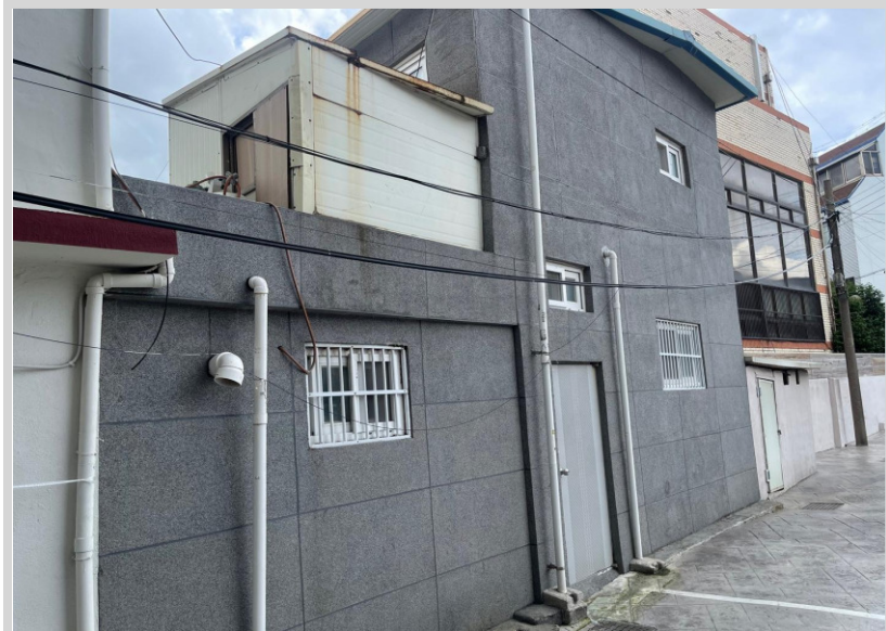
제시외 건물 ㄱ) 전경
