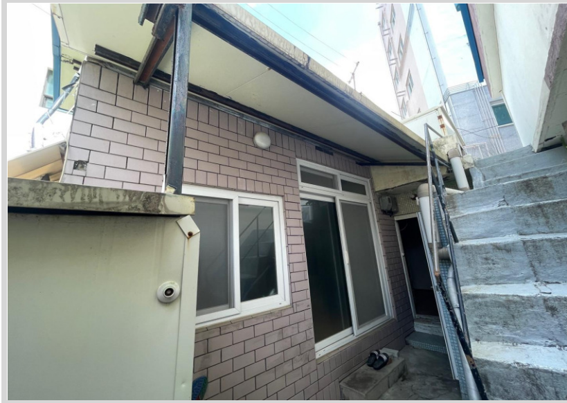
본건 토지 전경 및 제시외 건물 ㄱ) 1층, ㄴ) 전경
