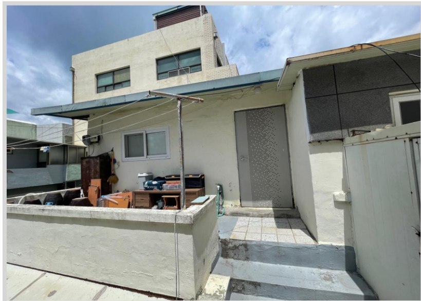
제시외 건물 ㄱ) 2층 전경
