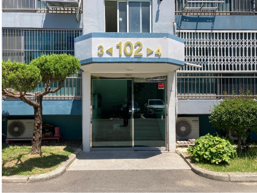
본건 전경(공동현관 출입문)
