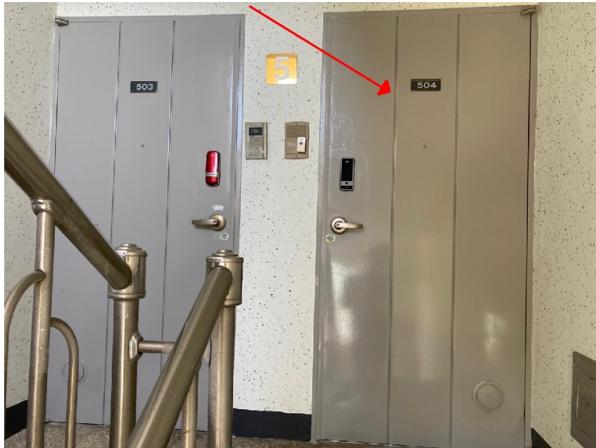
본건 기호(1)전경(단위세대 출입문)
