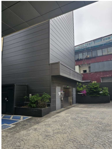
본건 기계식 주차장
