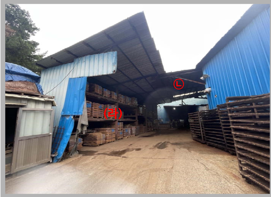
【일련번호 라) 전경, 제시의 건물㉔】
