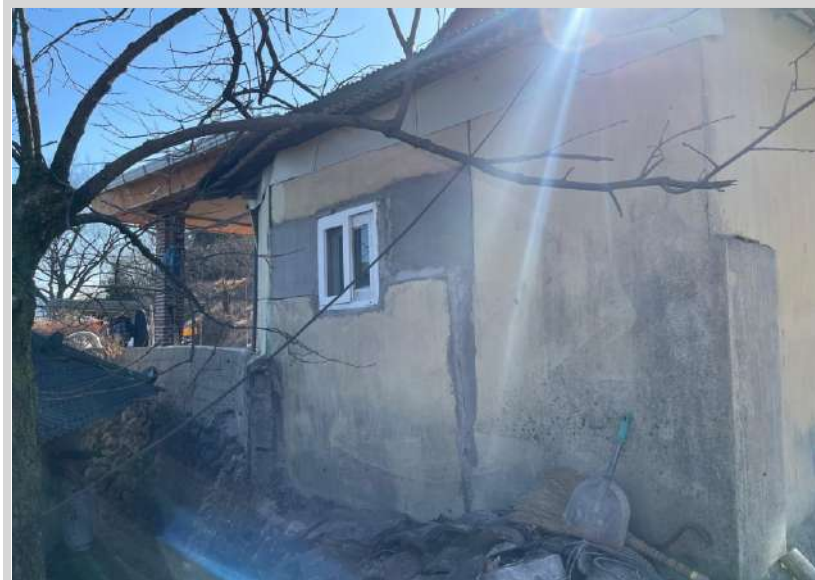
제시외 건물 ㄱ) 전경
