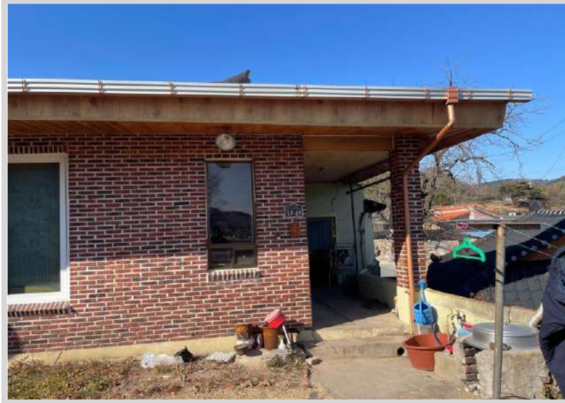
제시외 건물 ㄴ) 전경
