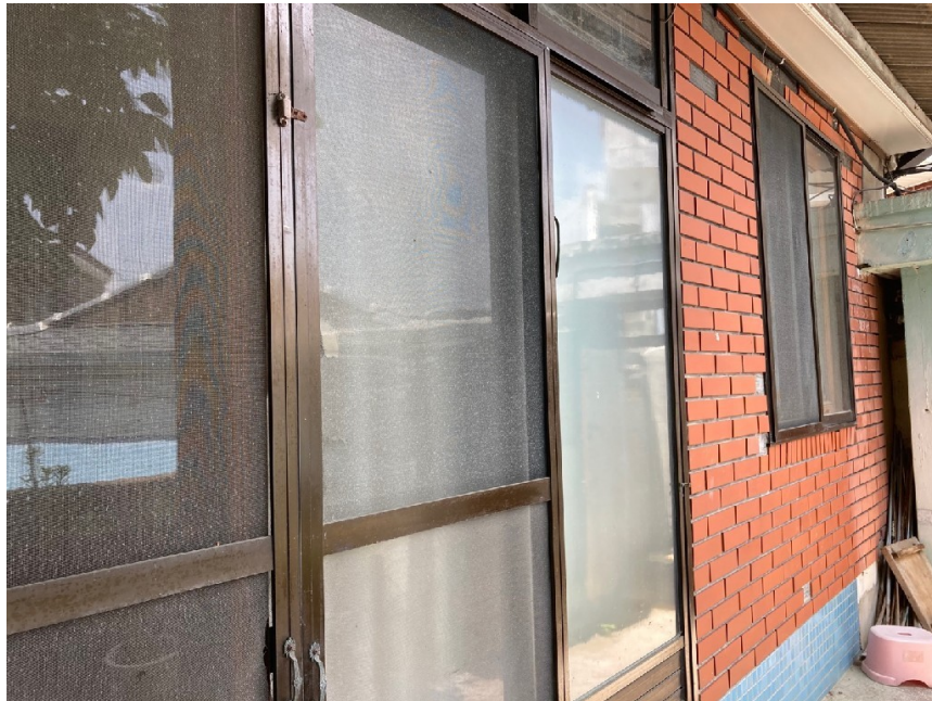
본건 기호(1)토지 및 기호(2)건물 전경
