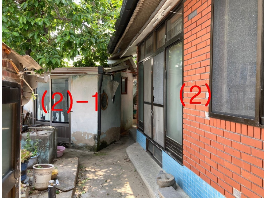
본건 기호(1)토지 및 기호(2),(2)-1건물 전경
