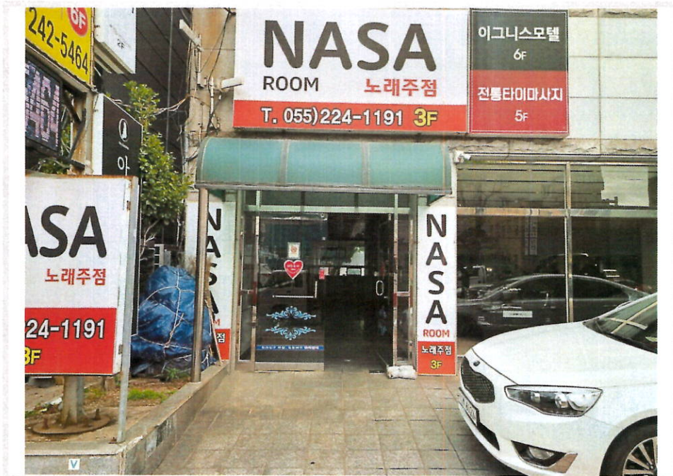
본건 공동 출입문
