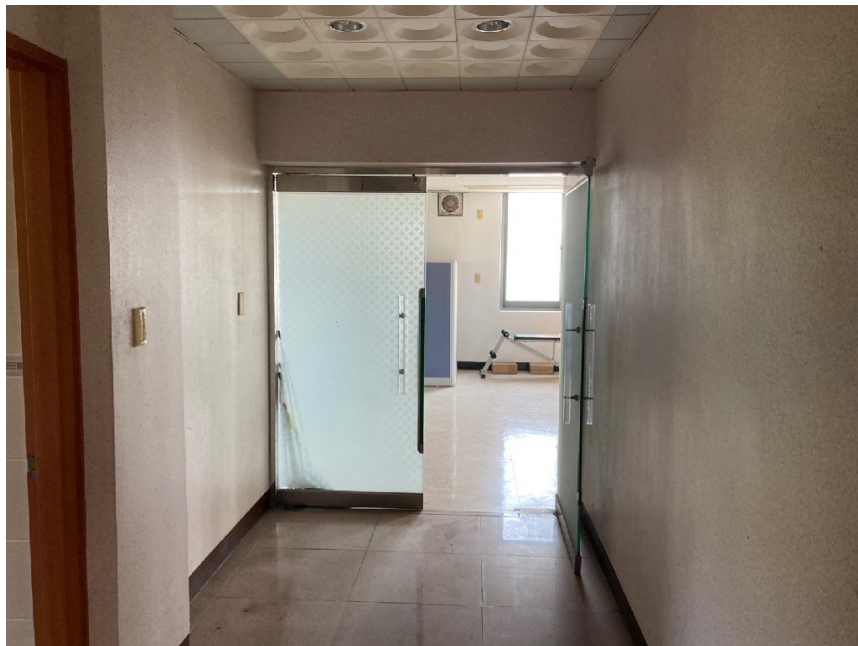
본건 기호(2)건물 전경(출입문)
