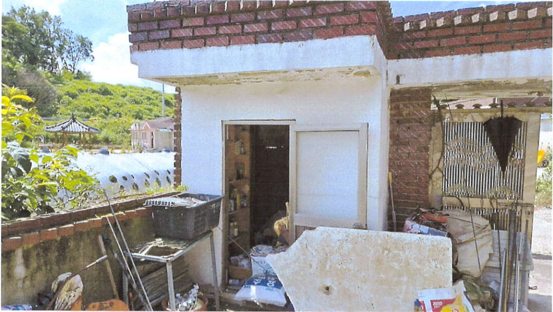
제시외 건물 기호 ㄷ 사진
