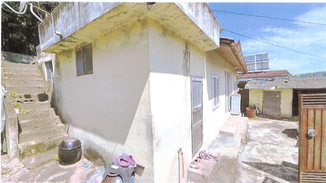
제시외 건물 기호 ㄹ 사진
