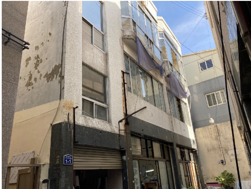
본건 기호(2)토지 및 기호(3)건물 전경
