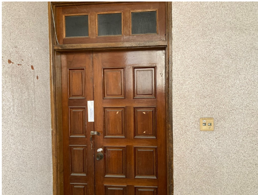
본건 기호(3)건물 내부(2층)
