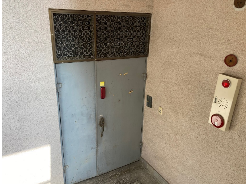
본건 기호(3)건물 내부(3층)
