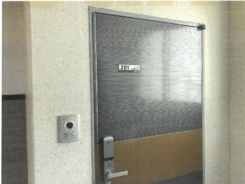
본건 기호2 단위세대 출입문
