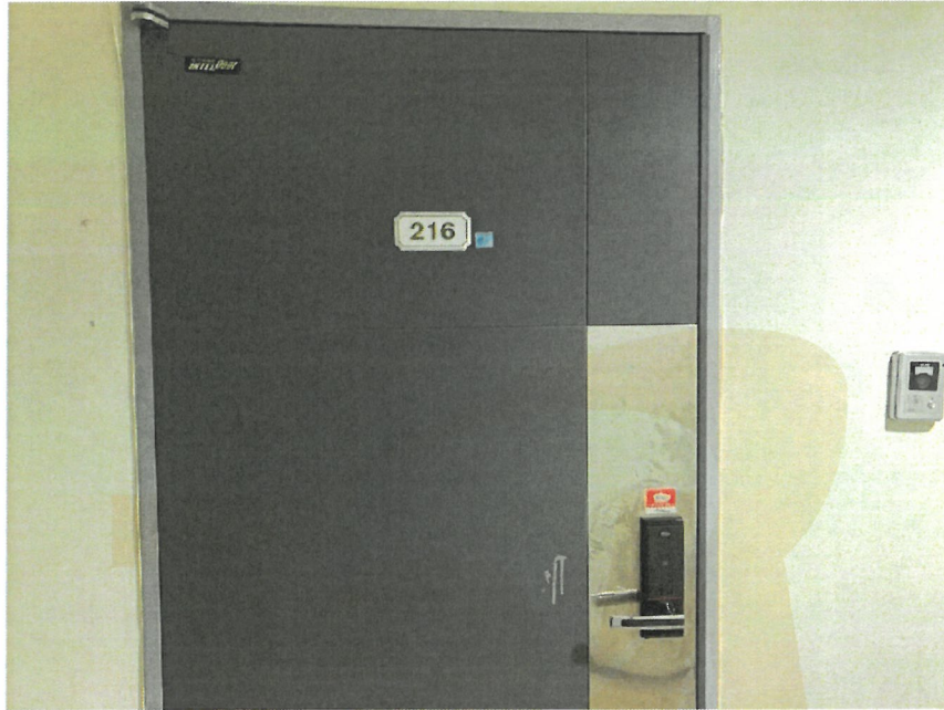
본건 기호1 단위세대 출입문
