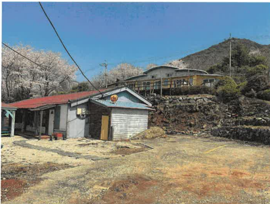
기호3) 건물 및 제시외 건물 e, ㄱ 부분
