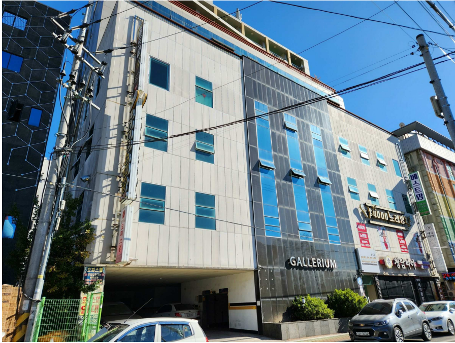
본건 정면, 외벽 등의 전경
