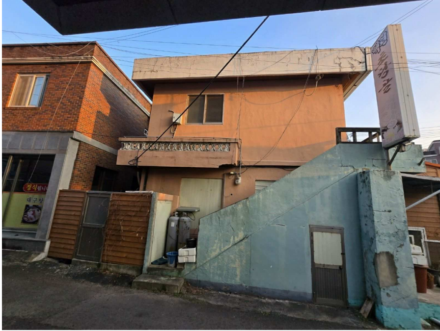
기호(2) 기존 철근콘크리트조부분 외부
