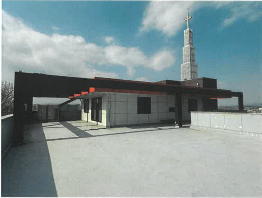
본건 기호 (2) 건물 4층 전경
