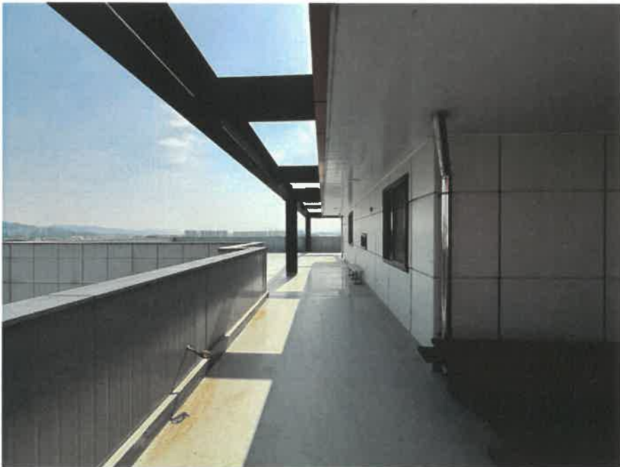
본건 기호 (2) 건물 4층 전경
