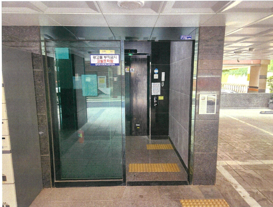
【 본건 전체 건물 출입구 】
