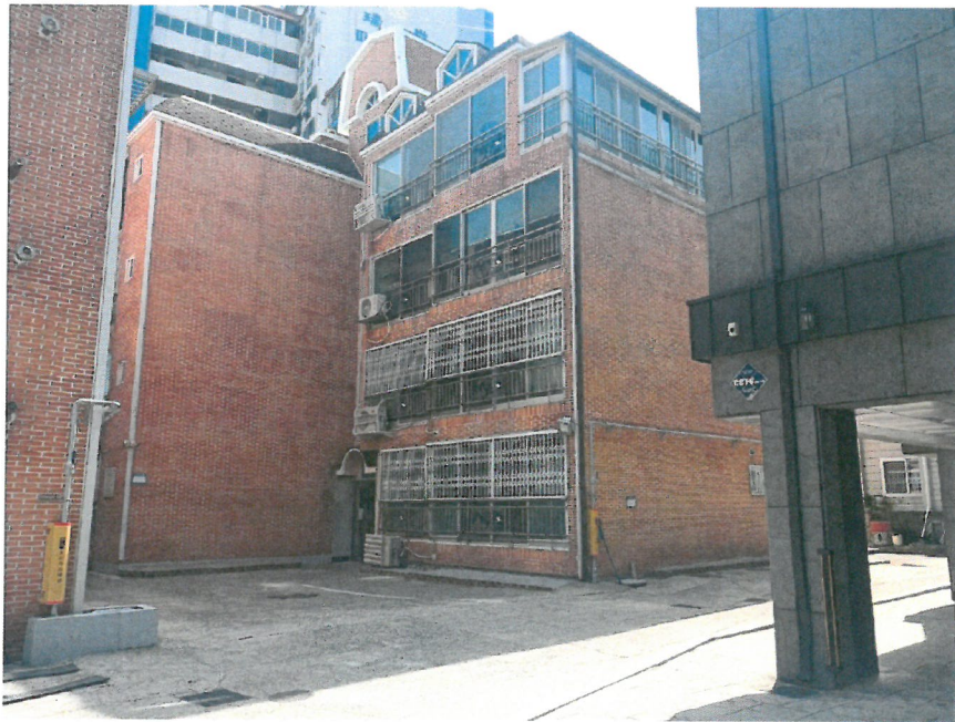
대상물건 1동 전경
