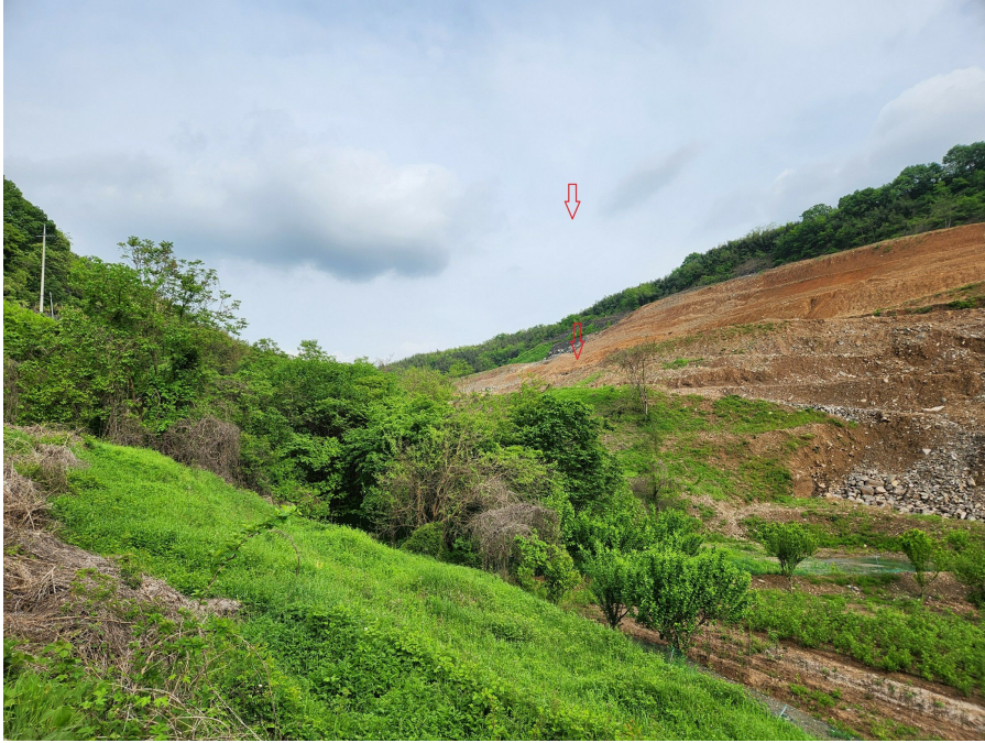
본건의 전경 북서측에서 남동측을 향하여 촬영
