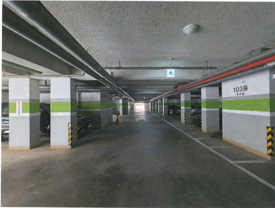
본건동 지하주차장 전경
