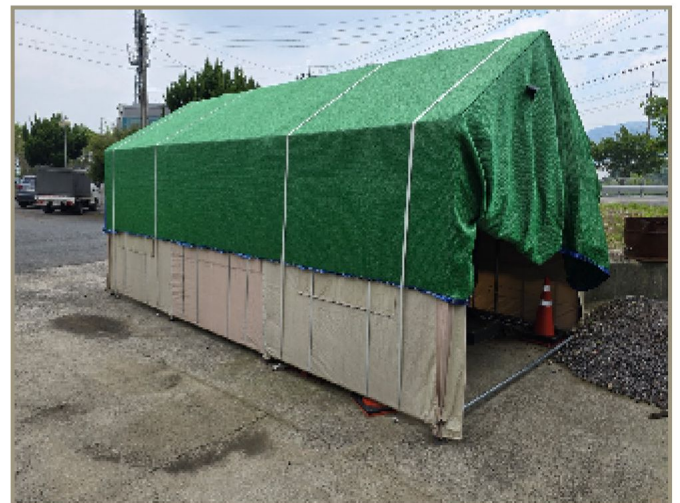
제시외건물 기호(ㄷ) 전경
