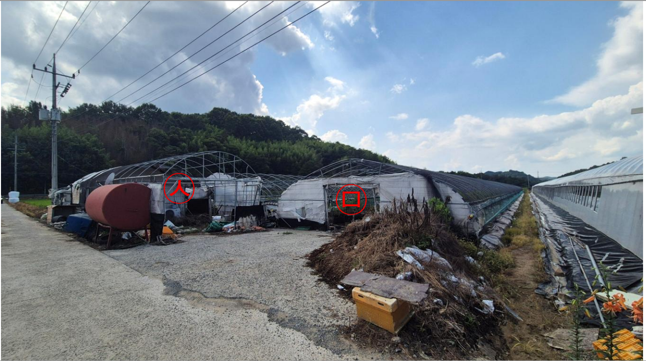
기호(2,3) 토지 전경(남동측) - 제시외물건㉠, 제시외건물㉡
