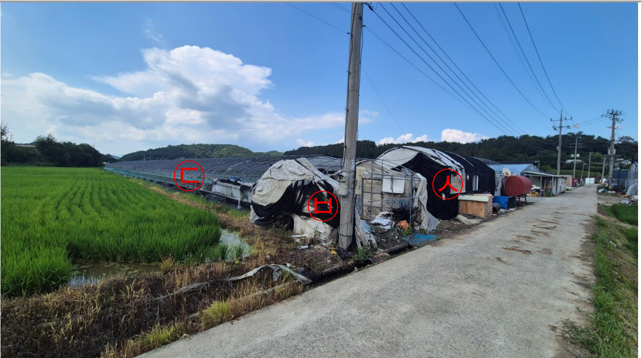
기호(2,3) 토지 전경(남측) - 제시외물건㉢,㉣, 제시외건물㉤
