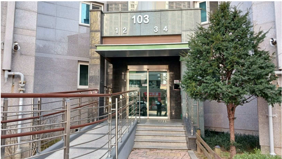
1층 출입구 전경
