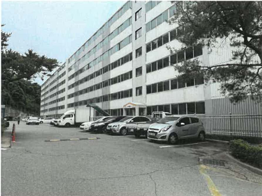
본건 외부 전경
