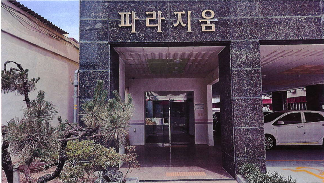
본건 건물 출입구 사진
