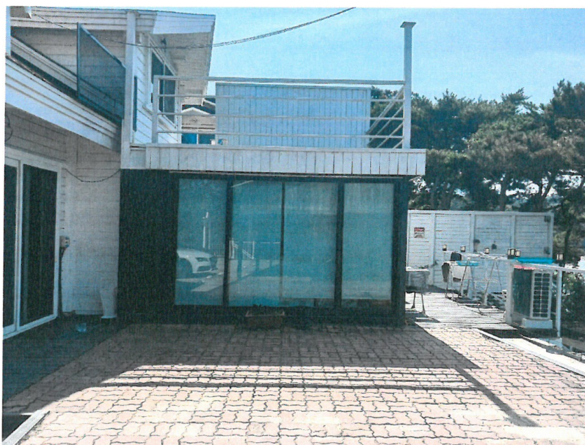
제시외 건물 ㄴ) 주방 및 다용도실 (증축신고 부분)
