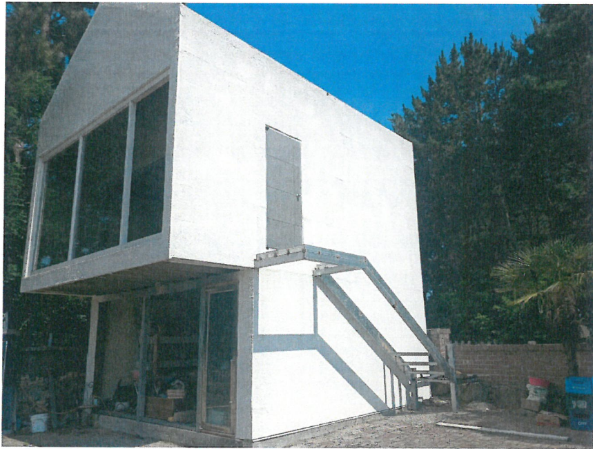
제시외 건물 ㄴ) 증축중인 건물
