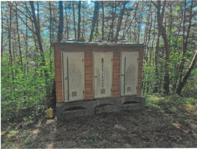
일련번호(2) 간이화장실(평가 제외) 전경
