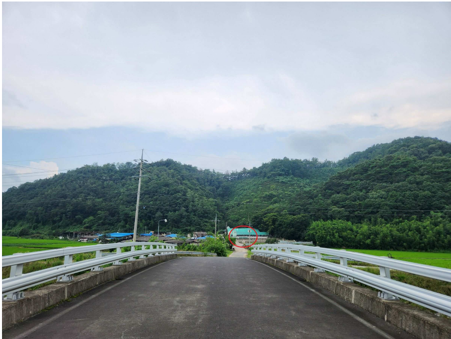
본건 및 부근의 상황 등 본건 북동측 약50 미터 지점에서 본건을 향하여 원거리 촬영
