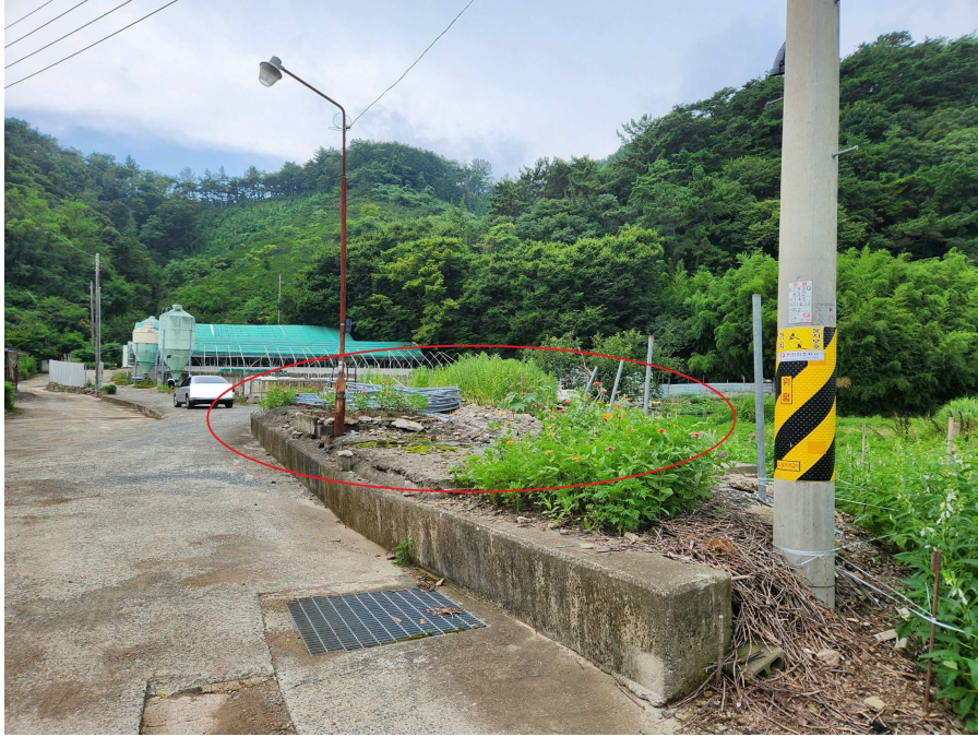
기호2 토지의 전경 북동측에서 남서측을 향하여 촬영
