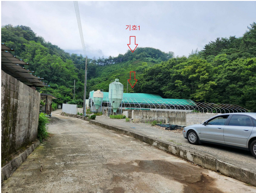
기호1 토지의 전경 북동측에서 남서측을 향하여 촬영
