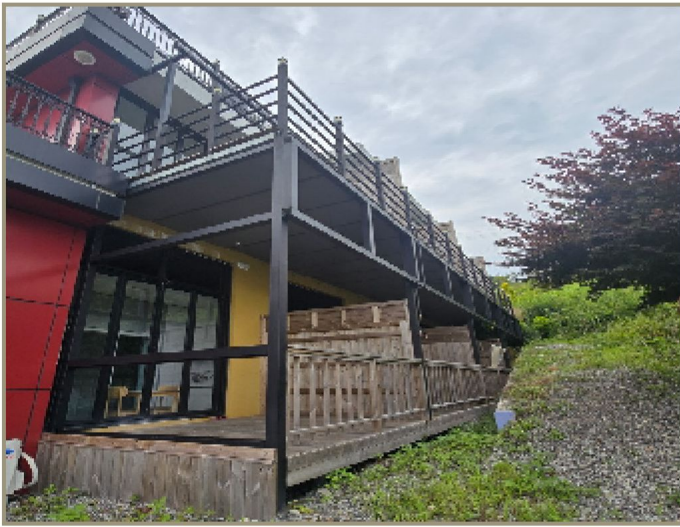
제시외건물 기호(바) 전경
