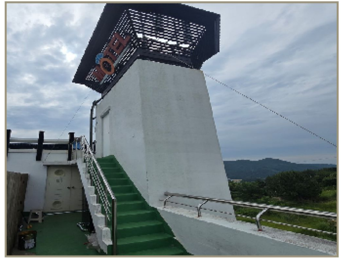
제시외건물 기호(ㄷ) 전경
