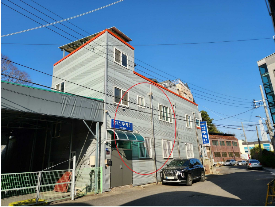
기호2 건물의 전경 서측에서 동측을 향하여 촬영
