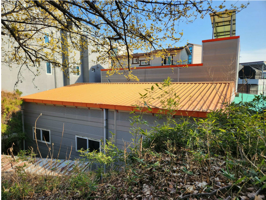
기호2 건물의 전경 북측에서 남측을 향하여 촬영
