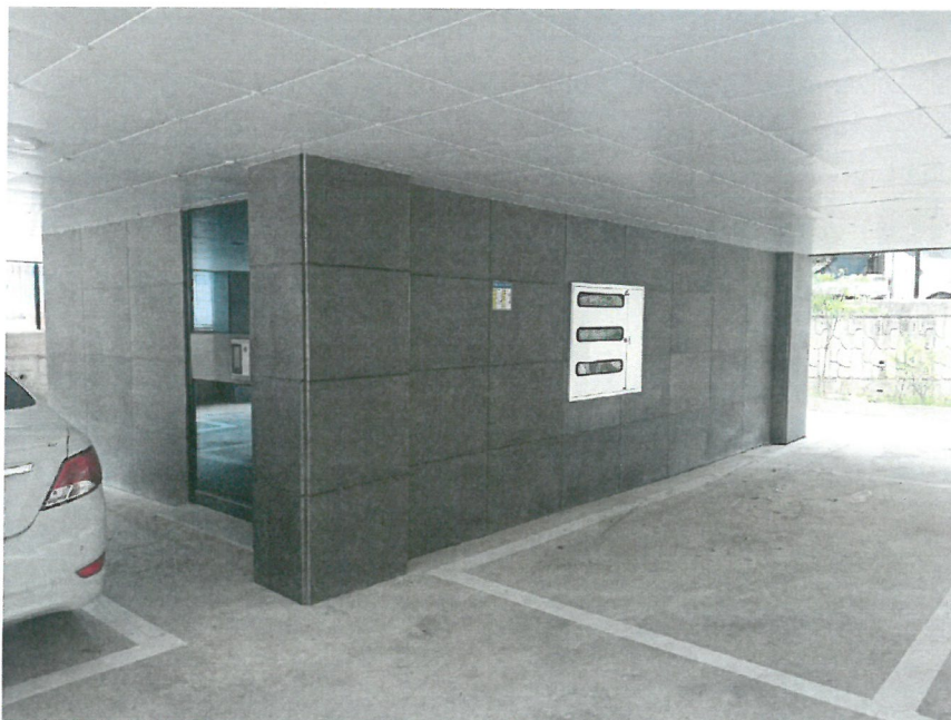
대상물건 1층 계단실 및 EV
