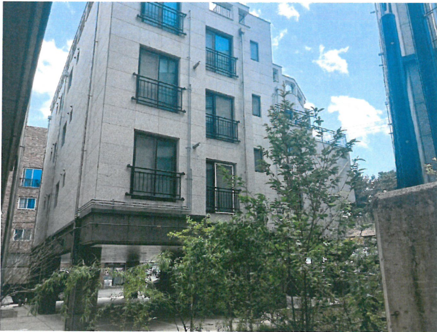
대상건물 후면 전경
