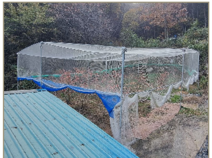
일련번호(4,5) 지상 철제구조물(평가제외) 전경
