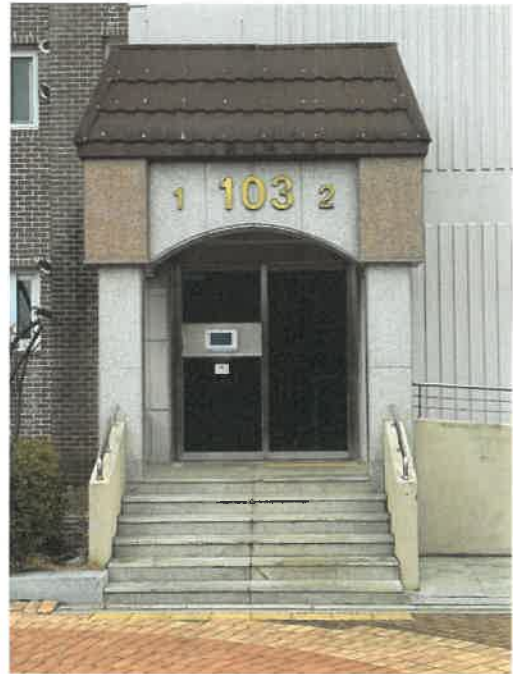
본건 기호(2) 출입구 전경
