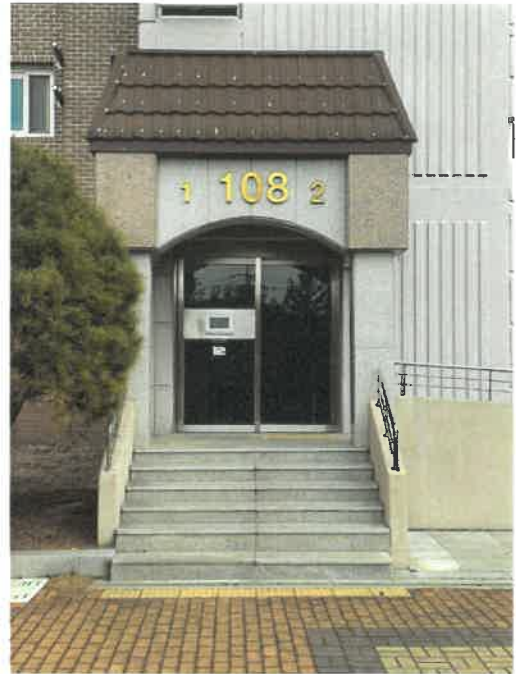
본건 기호(3) 출입구 전경
